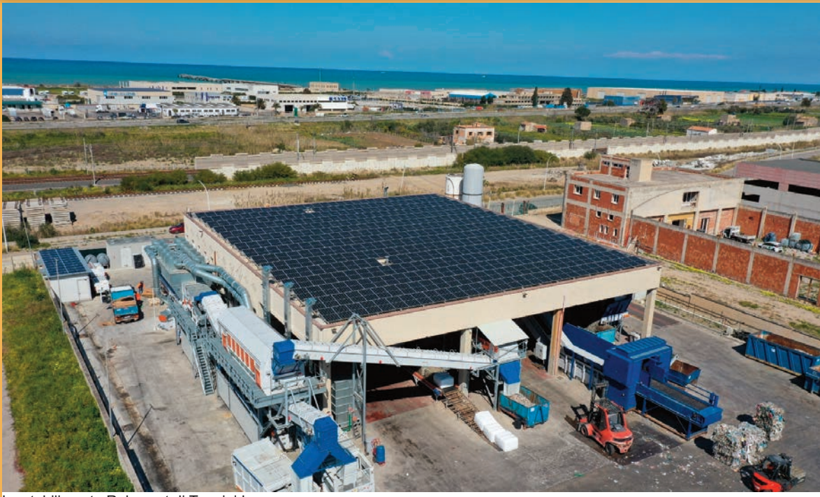
Lo stabilimento Rekogest di Termini Imerese
